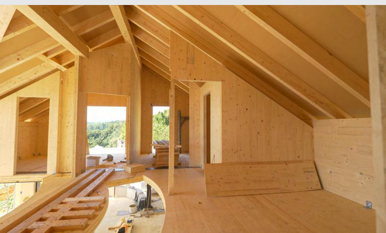
A construção CLT (*Cross Laminated Timber*) é um método inovador que utiliza painéis de madeira estruturalmente reforçados, criando edifícios sustentáveis e modernos.
